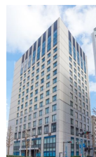
KDX横浜関内ビル
