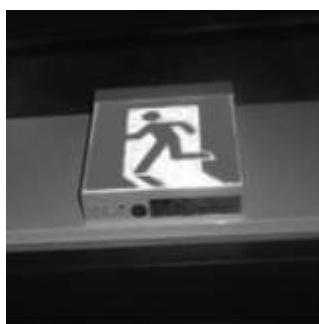
非常用誘導灯
