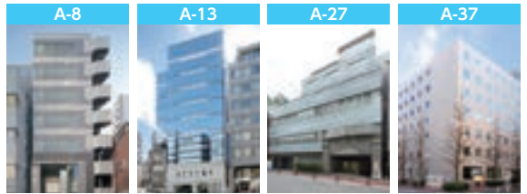
神田木原ビル KDX麴町ビル KDX鍛冶町ビル KDX御茶ノ水ビル
