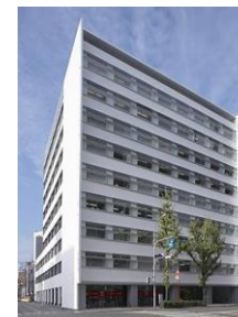
A53 KDX博多南ビル
