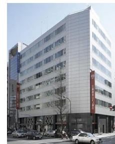
A40 虎ノ門東洋ビル
