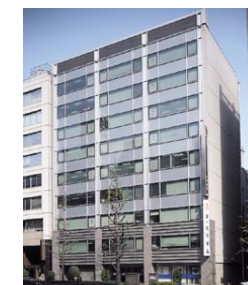
KDX日本橋313ビル (株式会社日本設計による耐震診断報告書に基づく)
