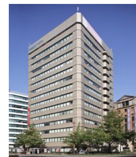
A79 名古屋駅前桜通ビル
