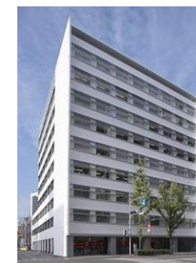
A53 KDX博多南ビル
