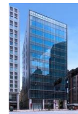
KDX新橋駅前ビル
