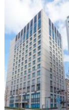
KDX横浜関内ビル
