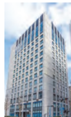
KDX横浜関内ビル
