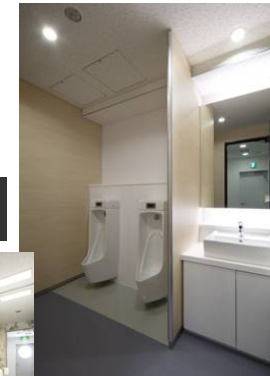
改修後 トイレ
