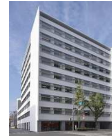
A53 KDX博多南ビル
