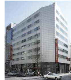
A40 虎ノ門東洋ビル
