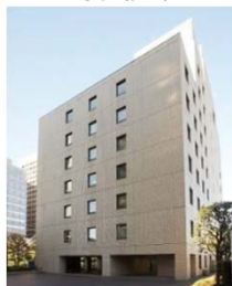
KDX川崎駅前本町ビル
