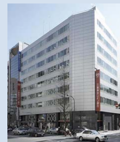
虎ノ門東洋ビル
