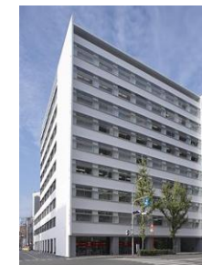
【KDX博多南ビル】 所在：福岡県福岡市 建築時期：1973年6月
