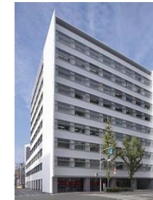
A53 KDX博多南ビル
