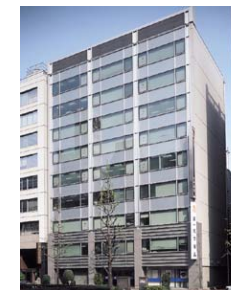
A1 KDX日本橋313ビル
