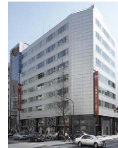
A40 虎ノ門東洋ビル
