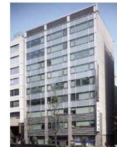
A1 KDX日本橋313ビル
