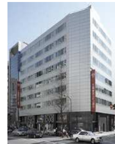
A40 虎ノ門東洋ビル
