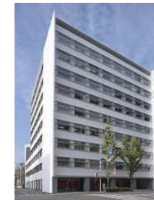
A53 KDX博多南ビル
